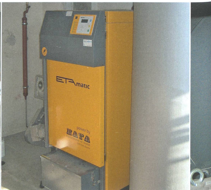
Schnitzelkessel in einer landwirtschaftlichen Liegenschaft, der auch einen Nahwärmeverbund der nahe gelegenen Einfamilienhäuser versorgt.
