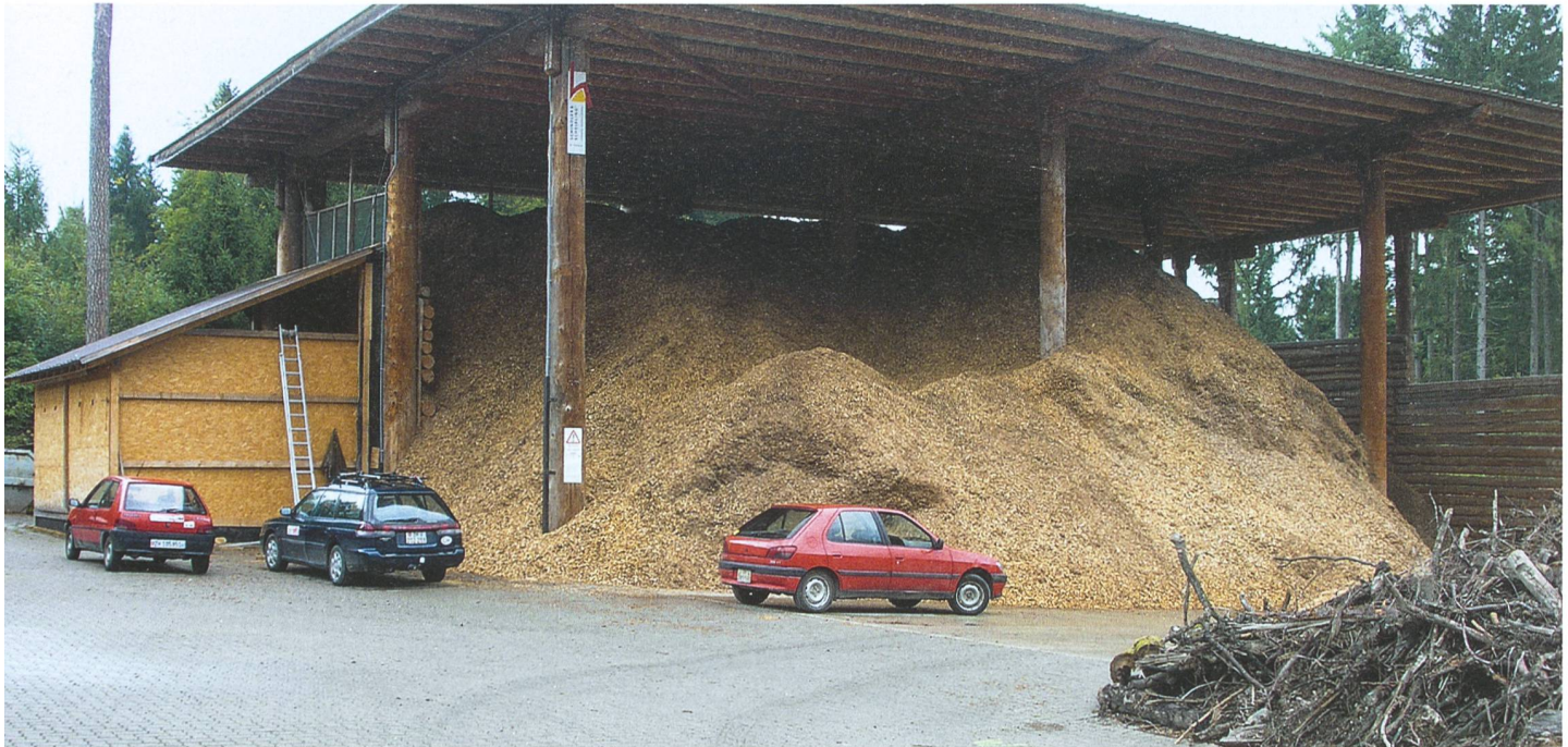
Ein zuverlässiges Angebot ist nur möglich, wenn mindestens ein Teil der Schnitzel in einem Schopf gelagert werden kann. Links im Bild eine Versuchsanlage zur Trocknung von Cheminéeholz mit Sonnenkollektor. Ziel ist es, den Trockner im März zu beschicken und Ende August die trockenen Scheiter zu entnehmen. (Bilder: Ruedi Gnädinger)
