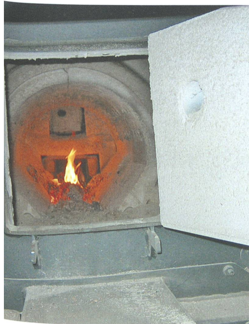
Die Auskleidung des Feuerraumes und der Feuerungsrost sind typische Verschleissteile. Sie sollten daher einfach ausgewechselt werden können.
