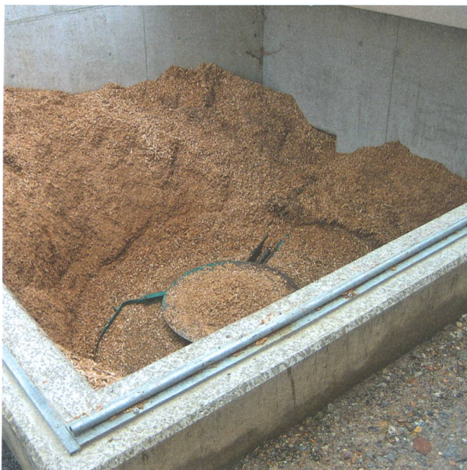
Ein Schnitzelbunker mit einer Kapazität für 14 Tage und ein einfacher Schnitzelaustrag sind wesentliche Massnahmen gegen zu hohe Kosten. Zur Langzeitlagerung und Nachtrocknung sind offene Schnitzelhallen wesentlich geeigneter und billiger.
