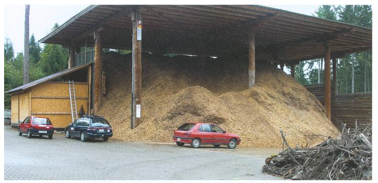
Ein zuverlässiges Angebot ist nur möglich, wenn mindestens ein Teil der Schnitzel in einem Schopf gelagert werden kann. Links im Bild eine Versuchsanlage zur Trocknung von Cheminéeholz mit Sonnenkollektor. Ziel ist es, den Trockner im März zu beschicken und Ende August die trockenen Scheiter zu entnehmen. (Bilder: Ruedi Gnädinger)
