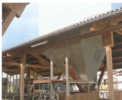
Kraftfütterstationen aus Edelstahl eignen sich als feste Installation für Laufställe. (Bild: Ueli Zweifel)
