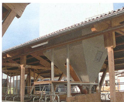
Kraftfutterstationen aus Edelstahl eignen sich als feste Installation für Laufställe. (Bild: Ueli Zweifel)
