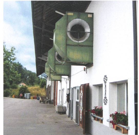
Trockenere Ansaugluft durch die südliche Exposition und die Montage unter dem Dach.
