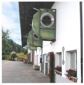
Trockenere Ansaugluft durch die südliche Exposition und die Montage unter dem Dach.
