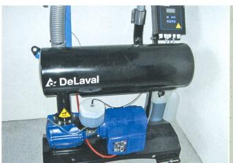
Vakuumpumpe mit im Elektromotor integriertem Frequenzumrichter. Die Drehzahl der Pumpe wird nach dem Soll-Vakuum geregelt. Mit der üblichen Technik wird generell zu viel Vakuum erzeugt und dieses über das Vakuumregulierventil korrigiert.
