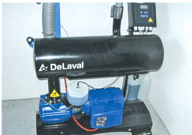
Vakuumpumpe mit im Elektromotor integriertem Frequenzumrichter. Die Drehzahl der Pumpe wird nach dem Soll-Vakuum geregelt. Mit der üblichen Technik wird generell zu viel Vakuum erzeugt und dieses über das Vakuumreguliventil korrigiert.
