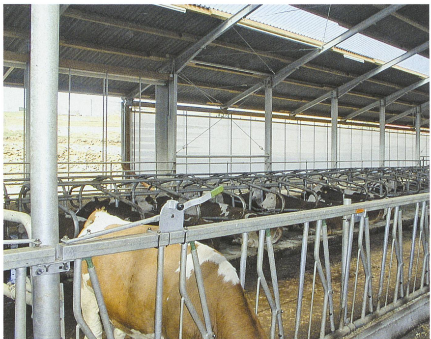
Ideal sind Windnetze, die sich bei Bedarf aufrollen lassen, damit eine minimale Luftströmung im Stall erhalten bleibt.
