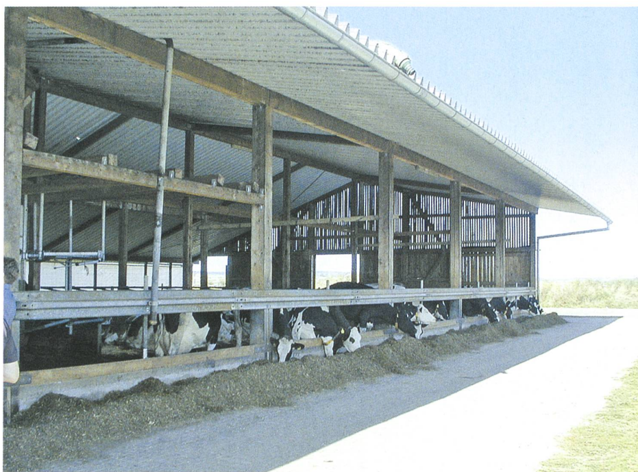
Mit grosszügigen Traufhöhen und ausladenden Dächern wird das Stallklima an Hitzetagen ausgeglichener und...
