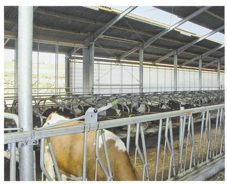
Ideal sind Windnetze, die sich bei Bedarf aufrollen lassen, damit eine minimale Luftströmung im Stall erhalten bleibt.
