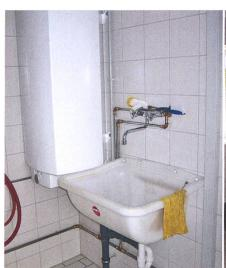
Wasch- und Warmwasserstation für einen Kälberstall mit eigenem Boiler (kein Wärmeverlust durch lange Leitungen). Der Waschtrog hat eine ideale Form und der Wasserbedarf ist dementsprechend gering.
