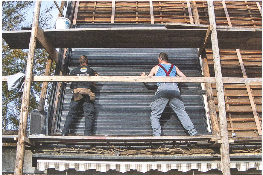
Montage von Sonnenkollektoren an einem Steildach. Anschliessend muss noch die Abdeckung angebracht werden. Eigenleistungen in Zusammenarbeit mit dem Installationsunternehmen sind hier durchaus möglich.
