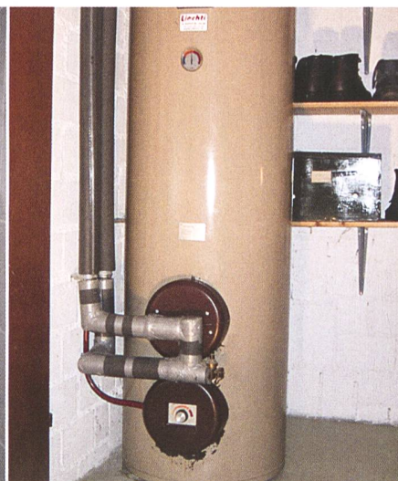
Einfacher Stehboiler mit Elektroheizregister und Zusatzregister für den Anschluss an den Heizungskreislauf.
