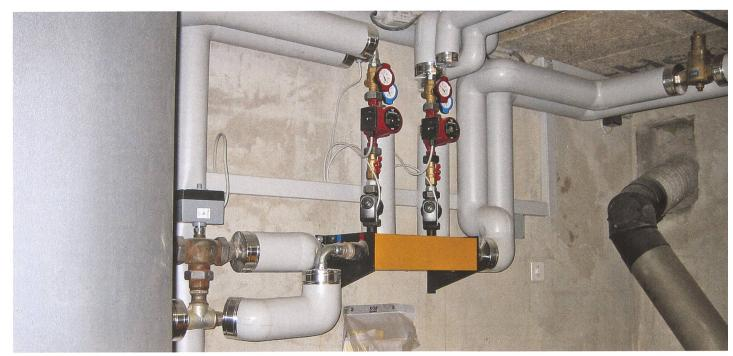
Von links nach rechts: Zentraler Wärmespeicher, Ladeventil (3-Weg-Ventil), 2 Umwälzpumpen und Mischventile für den Heizungskreislauf und die Boilerladung, Leitungen zu Stückholzkessel. (Bilder: Ruedi Gnädinger)
