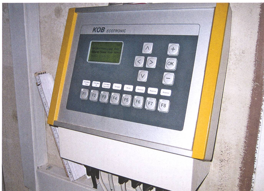
In modernen Kessel- und Heizungssteuerungen sind die Steuerungsmodule für die Boilerladung und die Solaranlage bereits enthalten.
