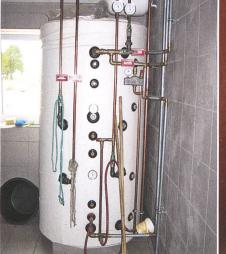
Zentraler Warmwasserspeicher einer Wärmerückgewinnungsanlage bei der Milchkühlung. Der Mehrverbrauch an Strom gegenüber der Milchkühlung ohne Wärmerückgewinnung ist sehr gering.
