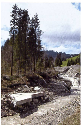
Surbrunnenbach in Unterberg mit ausgeweitetem Bett und fortgespülten Verbauungen.
