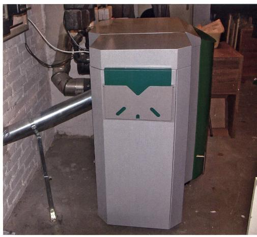
Pelletheizung: Granulierter Brennstoff so gut dosierbar wie Öl oder Erdgas. (Bild: Ueli Zweifel)
