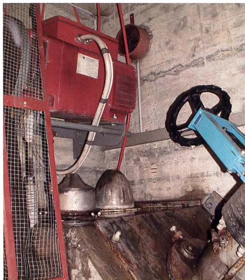
Ein Bartholdi-Generator liefert den Strom für die Bundalp.
