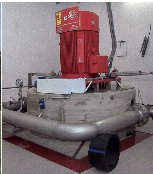
Drei Landwirte aus Aubonne VD bauten eine Druckleitung um ihre Felder ohne Diesel zu bewässern. Das Wasser, das nicht für die Bewässerung gebraucht wird, liefert Strom für 110 Haushalte. (Bilder: mo, zvg)
