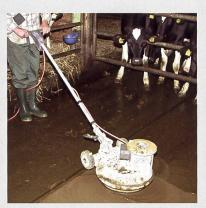
Abb. 3: Zu rauh gewordene GA-Beläge lassen sich durch gezieltes Abschleifen mehrmals sanieren.
