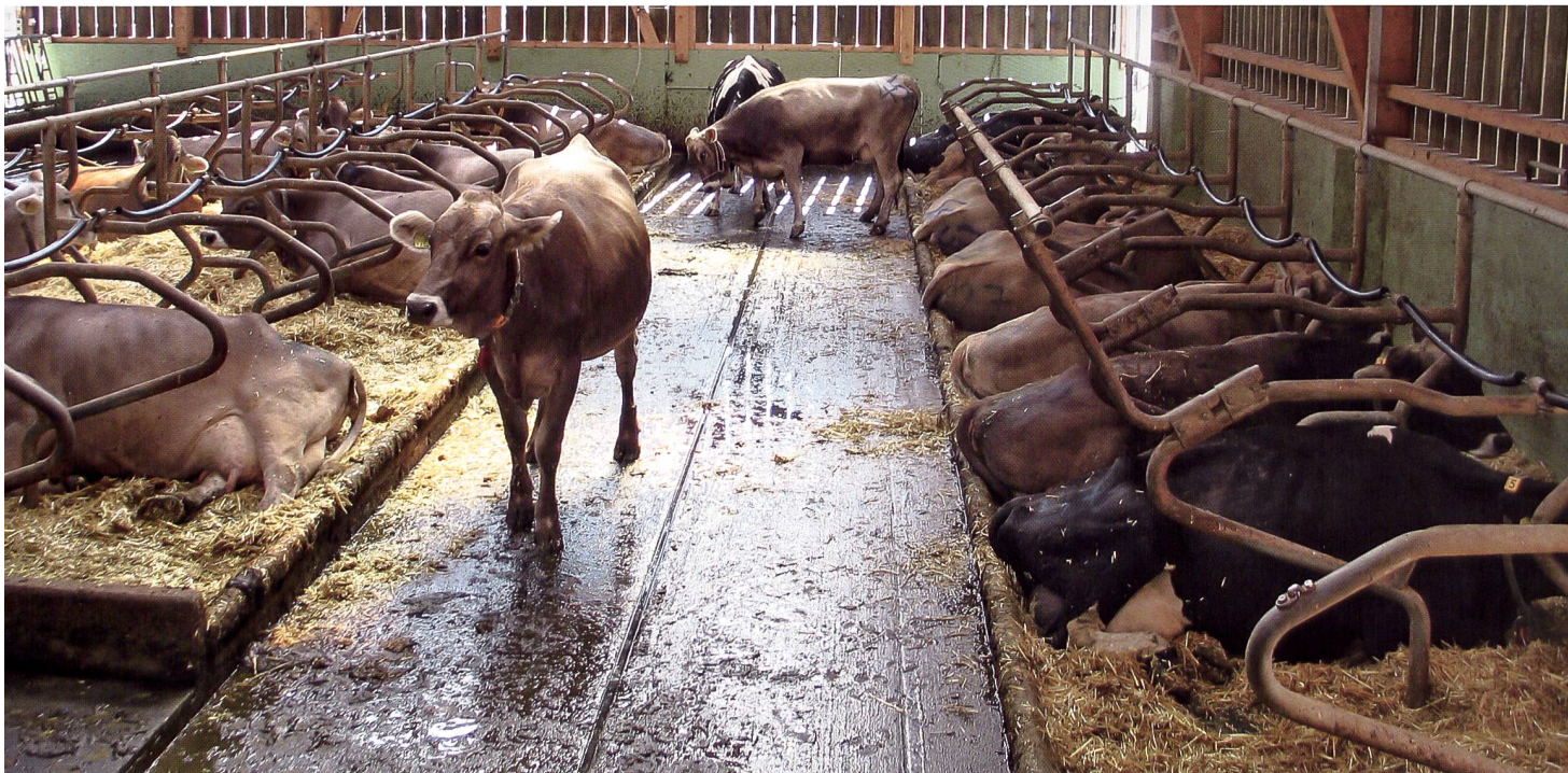
Abb. 1: Die Ausführung von Laufflächenbelägen in Rinderställen muss Anforderungen wie hohe Standfestigkeit und chemische Beständigkeit erfüllen.
