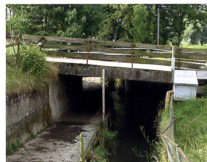
Neben einem Bach konnte hier mit geringem Aufwand eine Strassenunterführung realisiert werden.
