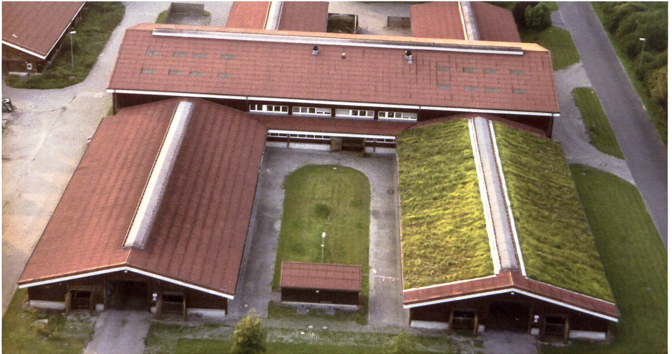
Ein Gründach senkt die Stalltemperatur, passt besser in die Landschaft, hält Wasser zurück und wirkt als Kleinbiotop. (Foto: Heiko Georg)
