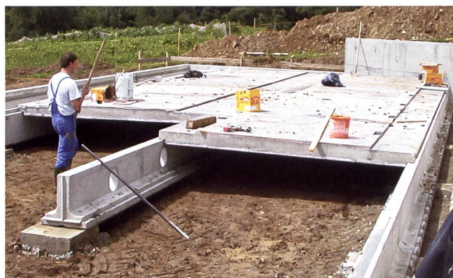
Über Rippenrohre oder einen Hohlraum unter dem Stall kann die Erdwärme genutzt werden. Im Winter wird die zugeführte Luft erwärmt, was Heizenergie spart. Im Sommer wird der Stall gekühlt. (Fotos: ART, Krieger, mo)
