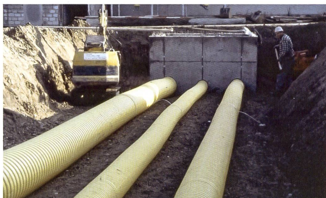
Über Rippenrohre oder einen Hohlraum unter dem Stall kann die Erdwärme genutzt werden. Im Winter wird die zugeführte Luft erwärmt, was Heizenergie spart. Im Sommer wird der Stall gekühlt. (Fotos: ART, Krieger, mo)
