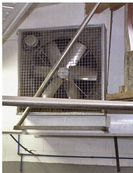
Über das Lüften gehen in einem gut isolierten Stall 80 Prozent der Wärme verloren. In eine effiziente Steuerung zu investieren lohnt sich doppelt.
