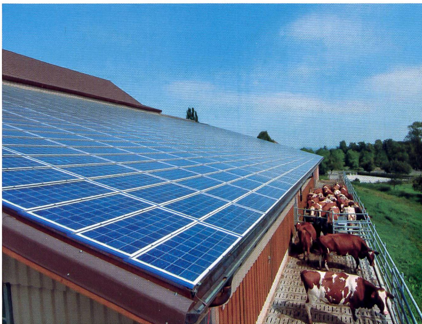
Abb. 1: Mit einer dachintegrierten Photovoltaikanlage kann sowohl Strom erzeugt als auch Dürffutter warm belüftet werden (Foto: Karl-Heinz Hug).
