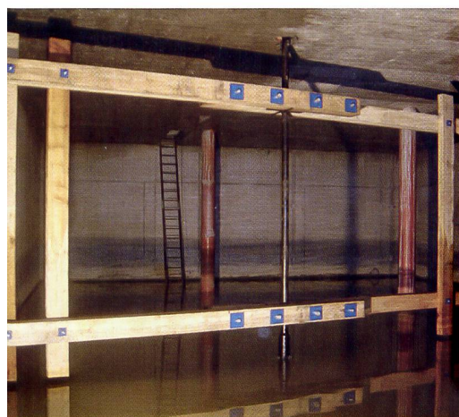
Flügelrührwerk mit 6,5m Durchmesser ohne Zwischenwand. Die Firma Mai AG in Huttwil hat sich auf den Bau dieses Typs Rührwerk spezialisiert. Jedes Rührwerk wird auf die besonderen Verhältnisse vor Ort abgestimmt (Werkbild Mai)
