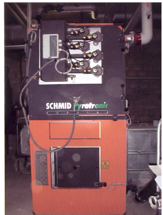
Um der wachsenden Nachfrage gerecht zu werden, wurde der erste Heizkessel von 360 kW mit einem zweiten von 720 kW ergänzt.
