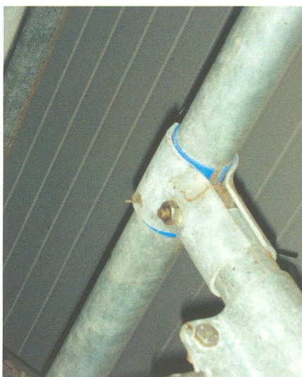
Die Unterlage aus Plastik an den Verbindungspunkten von verschiedenen leitfähigen Materialien wirkt als Isolation.
