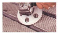
Abb. 17: Beschädigte Spaltenkanten erfordern eine Nachbearbeitung mit entsprechenden Werkzeugen. Durch den beidseitigen Materialabtrag an den Spaltenkanten erhöht sich damit die Spaltenweite um mindestens 5 mm.
