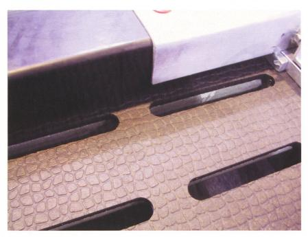
Abb. 11: Die Perforation des elastischen Gummibelags muss genau auf den Spaltenboden abgestimmt sein. Anpassungen an der Entmistungstechnik sind unerlässlich.
