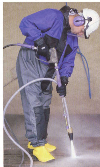
Abb. 10: Beim Einsatz des Verfahrens Hochdruck-Wasserstrahl ist eine komplette Körperschutz-Ausrüstung erforderlich. Eine entsprechende Arbeitsanweisung ist für dieses Verfahren unabdingbar.
