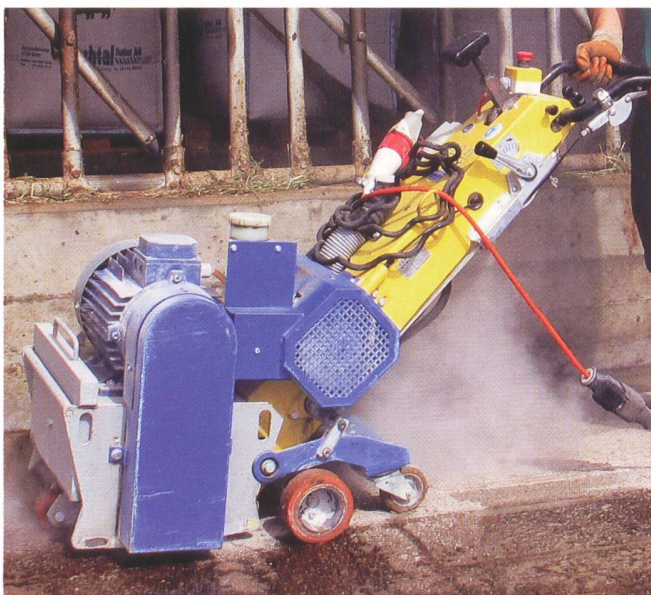
Abb. 4: Für das Fräsen von Rillen in homogener Form sind Geräte mit stufenlosem Fahrtrieb erforderlich. Minimale Geräte- und Werkzeuggewichte schonen das Betongefüge.
