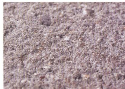
Abb. 9: Sanierungsverfahren Hochdruck-Wasserstrahl mit Strahlmittel 0,6–1 mm; erst durch komplettes Abtragen der Kalkschichten entsteht die erforderliche Rutschfestigkeit.
