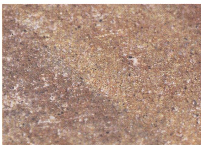
Abb. 6: Oberfläche eines Spaltenboden-Elements, auf dem die Sanierungsschritte erfolgten; Ausgangszustand nach 18 Jahren Nutzungsdauer.
