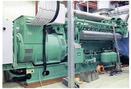
Blockheizkraftwerk: Der Motor verfügt über eine Leistung von 1,1 Megawatt (Bild: Hersener).
