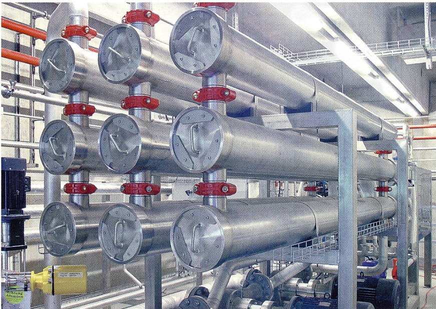
Umkehrosmose: Aus Permeat der Ultrafiltration entsteht der flüssige N/K-Dünger und Brauchwasser (Bild: Hersener).
