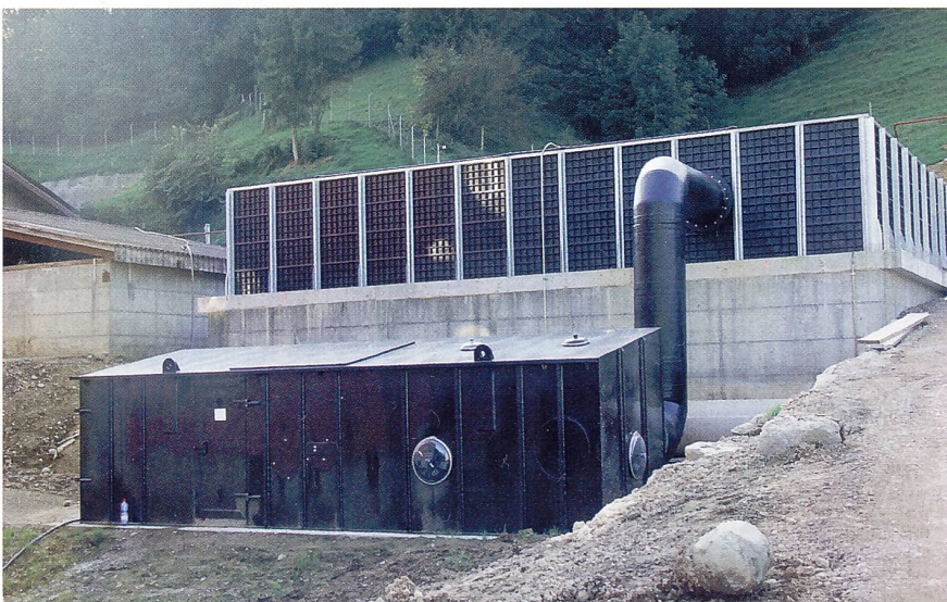
Biofilter: Die Abluft muss geruchsneutral gemacht werden, bevor sie an die Umwelt abgegeben wird.
