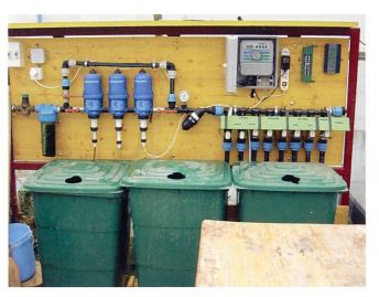
Einfache Schaltzentrale einer Bewässerungs- und Düngungsanlage. Links: Düngerzudosierung (blau), rechts elektrisch gesteuerte Ventile, die Bezeichnung der Bewässerungssektoren (auf grünen Etiketten), Filtriereinrichtungen und oben die Programmiereinheit sowie Messinstrumente zur Erfassung der klimatischen Daten.
