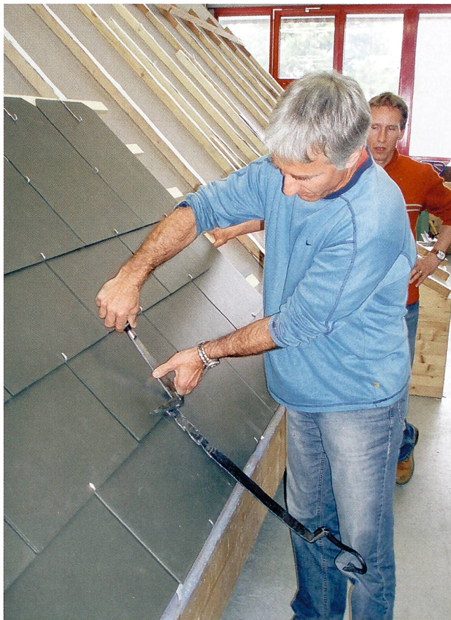
Mittels eines Nageleisens lassen sich Platten auch in der Dachmitte leicht lösen.
