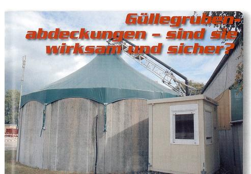
Abgedeckter FAT-Güllesilo von 400 m³. Versuchsbedingt befindet sich an der Spitze der Zeltabdeckung ein Absaugrohr für die kontrollierte Entnahme des Luft-Gas-Gemisches zur Analyse der Zusammensetzung. Die Kosten für die serienmässige Abdeckung liegen hier bei rund CHF 25 000.– oder CHF 63.–/m³ Güllelagervolumen, womit eine Güllegrube dieser Dimension praktisch um 50% teurer wird.
