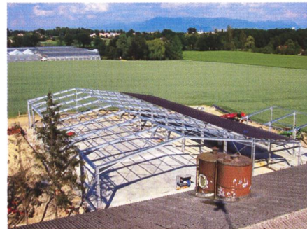
Letzte Montagen an der Tragkonstruktion
