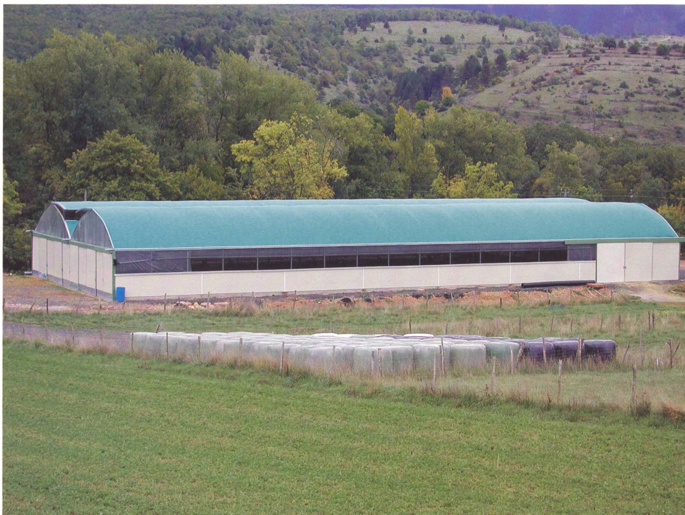
Der Multi-Chapelle-Stall besteht aus einer metallenen Tragkonstruktion und einer einfachen Dachhaut. (Bild: Agroscope FAT.)
