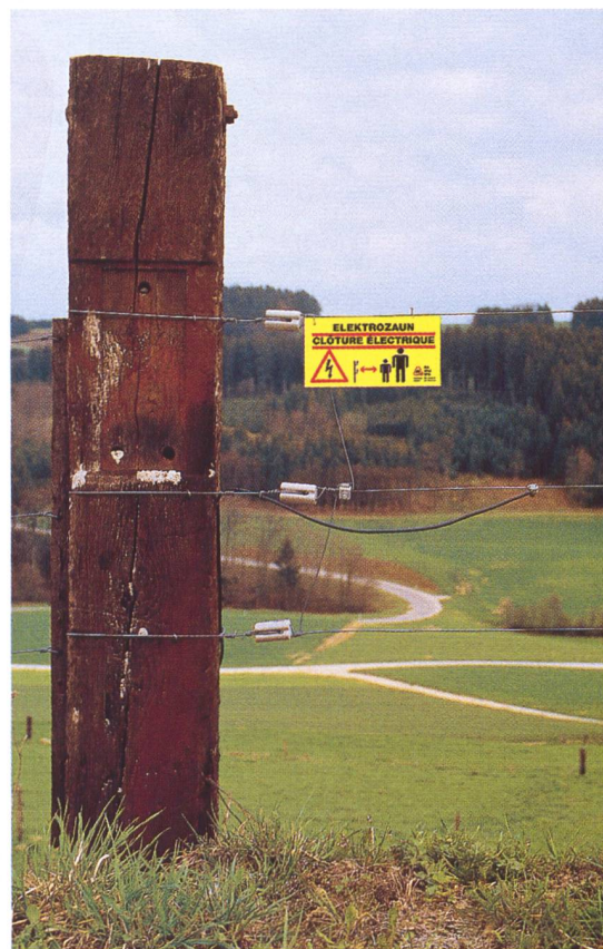
Gut verankerte Eckpfähle garantieren die Langlebigkeit.
