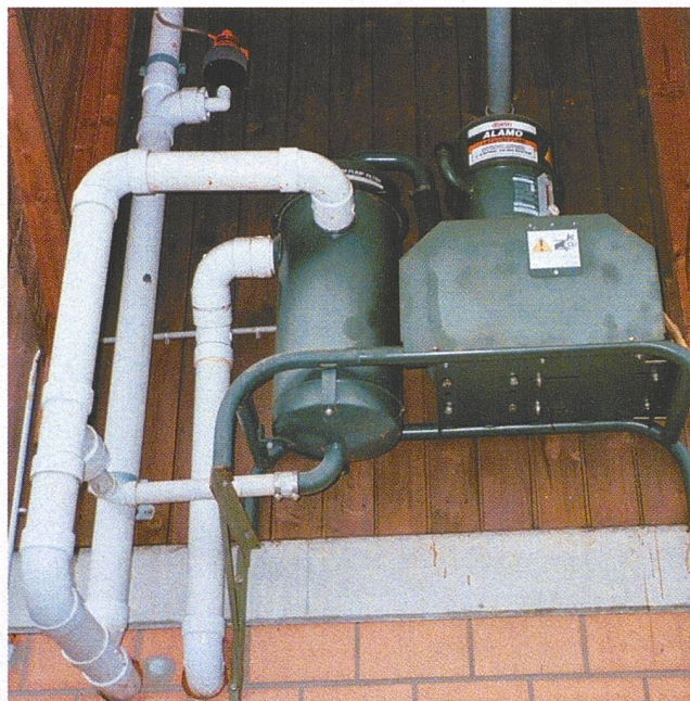
Abb. 2: Querschnittveränderungen und 90°-Bogen verursachen im Leitungssystem Wirbel im strömenden Medium und Druckveränderungen, die sich mit Schallgeschwindigkeit ( 330 \text{ m/s}^2 ) retour bewegen.
