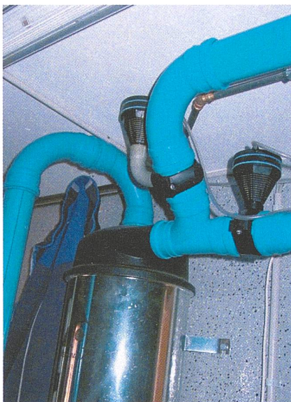
Abb. 3: Die Regelventile sollen nicht in der Nähe von Bögen montiert sein, sondern nach einer Beruhigungsstrecke von mindestens 3 d (d = Durchmesser der Leitung).
