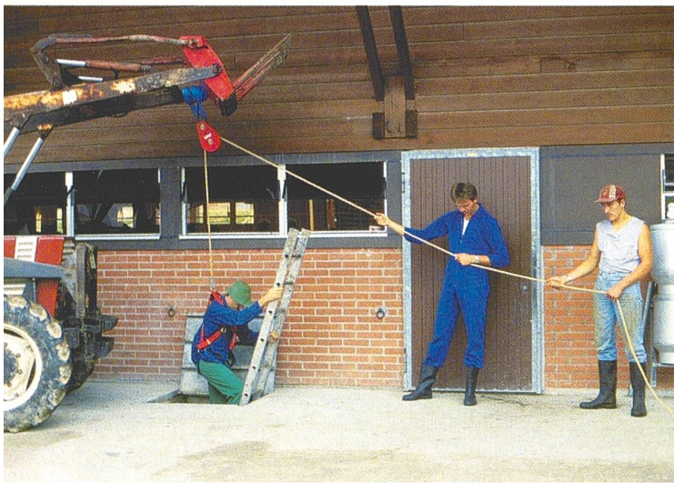
Mindestens zwei Personen sichern den Einstieg. Die vorgängige Durchlüftung ist unerlässlich. (Bilder BUL)
