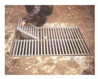
Die geschlossene oder abgedeckte Güllegrube braucht mindestens zwei gegenüberliegende Öffnungen, die mit Rosten abgedeckt sind. Ein Rost kann durch ein Kamin ersetzt sein (mindestens 40 cm Durchmesser).
