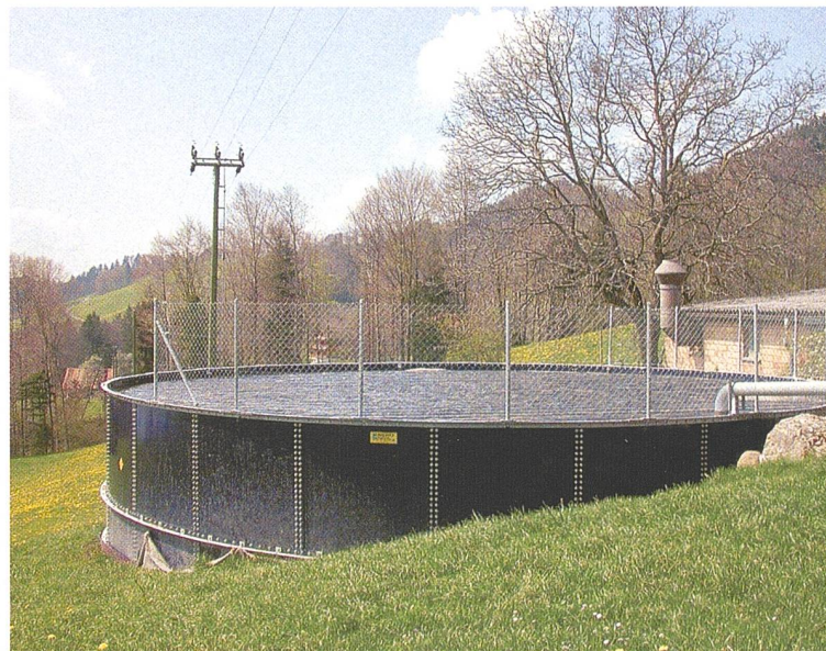
Offenes Güllesilo mit perforierter Schwimmfolie. Durch die feinen Löcher kann das Meteorwasser bis in die Gülle einsickern. (Foto: FAT Tänikon)
