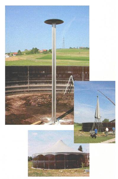
In der Mitte des runden Güllebeckens wird eine Stütze aus Chromstahl aufgerichtet. Die massgeschneiderte Blache wird auf die Stütze gehoben und an den Aussenwänden des Silos mit Spanngurten verspannt. (Fotos: FAT Tänikon)
