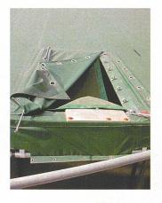
Die Gaskonzentration unter dem Membrankegeldach kann sehr massiv und gefährlich sein. Die Kontrollöffnung muss mit einem Netz ausgestattet sein. Es muss immer mit Explosionsgefahr gerechnet werden. (Foto: FAT Tänikon)
