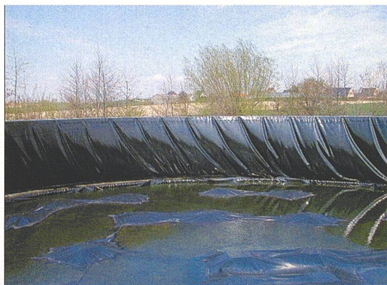
Folie mit Schwimmkörpern, die mit kleinen Öffnungen für den Gasaustausch durchsetzt sind. Die Folie ist nicht perforiert. Somit läuft das Meteorwasser nicht direkt in die Gülle hinein. (Foto: FAT Tänikon)
