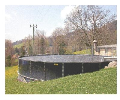
Offenes Güllesilo mit perforierter Schwimmfolie. Durch die feinen Löcher kann das Meteowasser bis in die Gülle einsickern. (Foto: FAT Tänikon)
