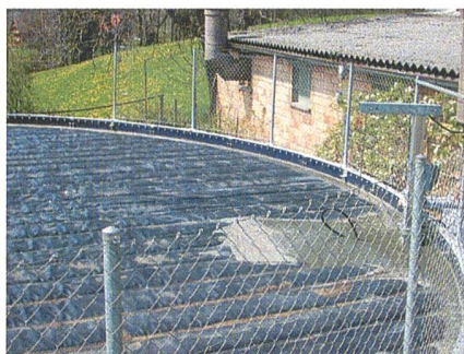
Aussparung in der Sandwichfolie im Bereich des Rührwerkes. (Foto: FAT Tänikon)
