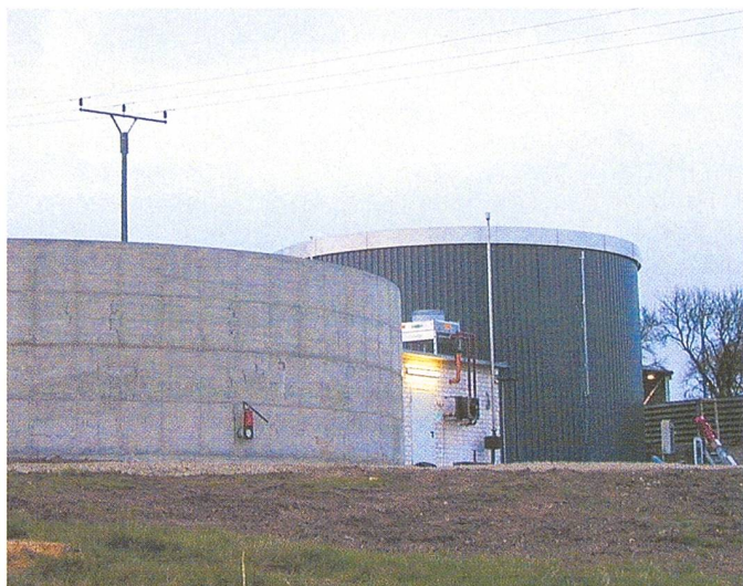
Konventionelle Biogasanlage der österreichischen Firma AAT. Im Fermenter muss man sich ein sog. Festbett für die Bakterienkultur vorstellen oder aber einen Membranabscheider als Zusatzinstallation. (Firmenbild)
