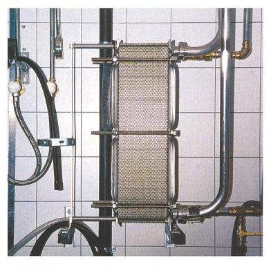
Plattenkühler: Die hohe Wärmeleitfähigkeit der Edelstahlplatten bewirkt eine Abkühlung der Milch bis auf 4°C über der Eintrittstemperatur des Kühlwassers in Trinkqualität.
