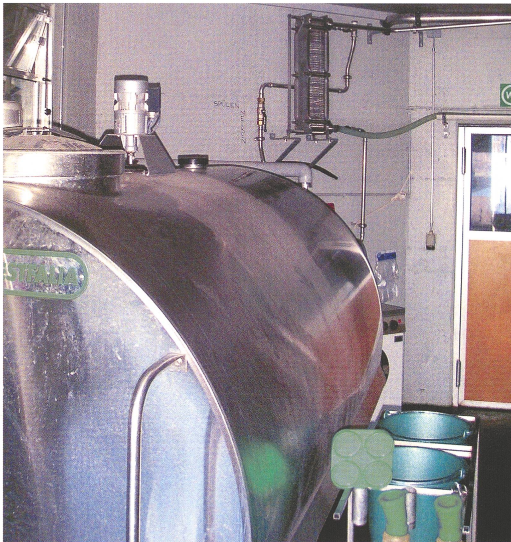
Direktverdampferanlage: Thermostatische Expansionsventile regulieren die Kühltemperatur knapp unter dem Gefrierpunkt, was die rasche Kühlung ohne Eisbildung begünstigt.
