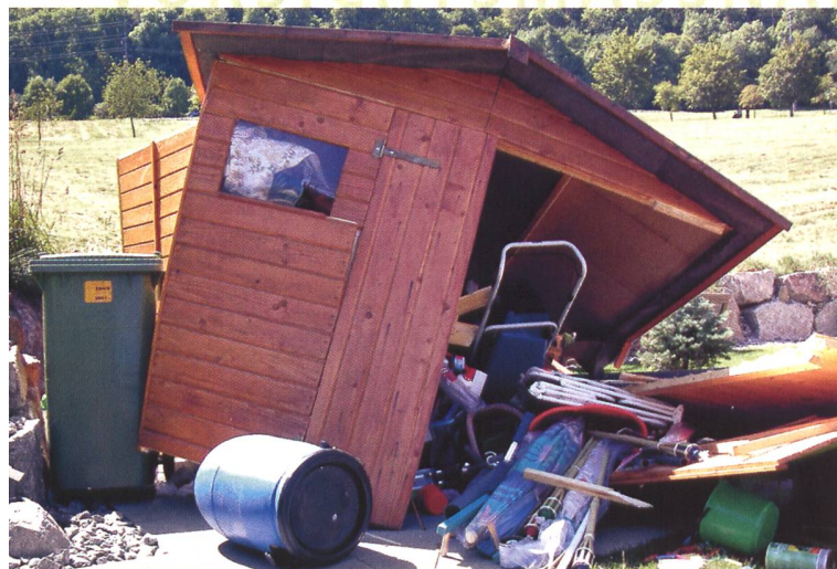
Glimpflich abgelaufen: Eine Rundballen demolierte dieses Gartenhaus und dessen Inhalt sehr erheblich. (Bild: Hansueli Fischer, «Die Botschaft», Döttingen AG)
