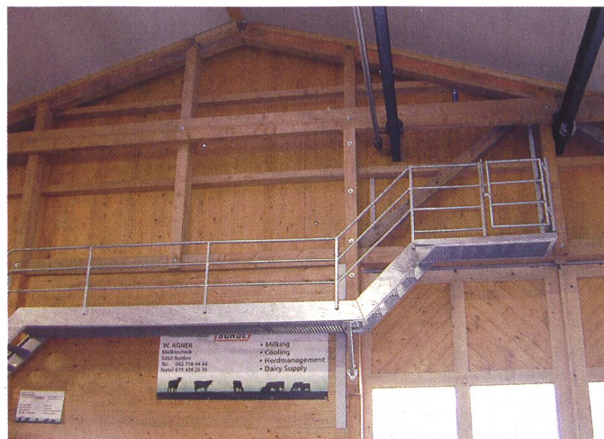
Ein sicherer Aufstieg auf den Kran bieten Treppen mit Geländer. Auch nach der Wegfahrt des Kranes muss die Treppe mit einer Türe verschlossen sein.
