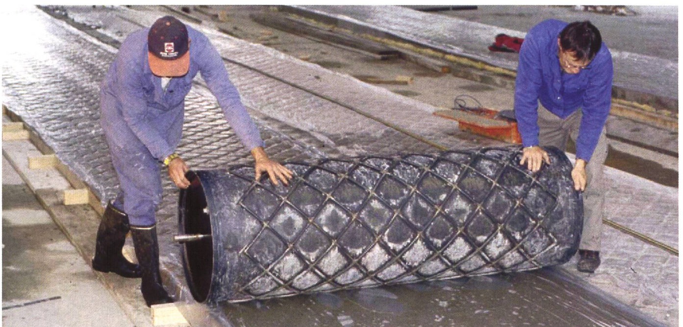
Die Stahlwalze für das Profilieren muss einen grossen Durchmesser aufweisen; mit 60 cm lässt sie sich von zwei Personen recht gut vorwärtsbewegen. Dank dem Auflager (Schalung und/oder Führungsschiene) kann die Walze während der Wartezeiten auf der Fläche verbleiben.
