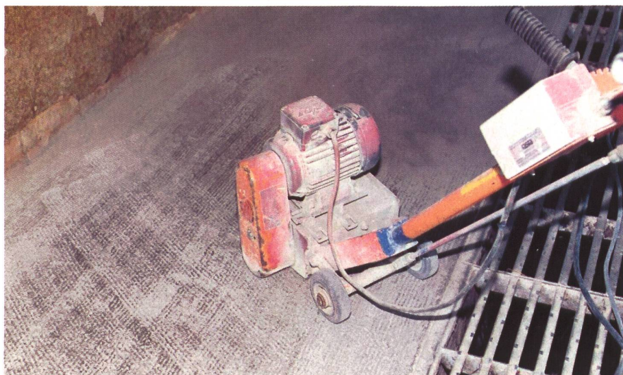
Durch ganzflächiges Aufräumen wird eine feinraue Oberfläche erreicht. Die rutschhemmende Wirkung ist je nach Betonqualität und mechanischer Beanspruchung maximal zwei bis drei Jahre gegeben.
