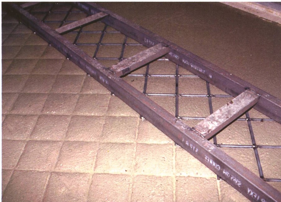
Eine offene Stempelkonstruktion ermöglicht die Kontrolle beim Eindrücken und ein präzises Ansetzen an die bereits profilierte Fläche.
