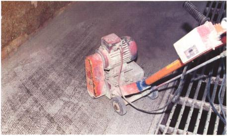
Durch ganzflächiges Aufrauen wird eine feinraue Oberfläche erreicht. Die rutschhemmende Wirkung ist je nach Betonqualität und mechanischer Beanspruchung maximal zwei bis drei Jahre gegeben.
