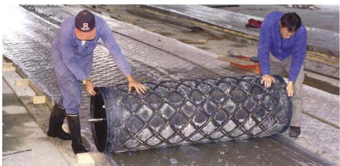
Die Stahlwalze für das Profilieren muss einen grossen Durchmesser aufweisen; mit 60 cm lässt sie sich von zwei Personen recht gut vorwärtsbewegen. Dank dem Auflager (Schalung und/oder Führungsschiene) kann die Walze während der Wartezeiten auf der Fläche verbleiben.
