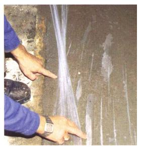
Der Zeitpunkt für das Profilieren von Frischbeton wird mit der Fingerprobe bestimmt. Je nach Anliefer- und Einbringbedingungen kann dies stark variieren.
