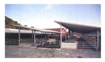
Stall für die Mutterkuhhaltung: Drei Pultdächer überdecken die beiden Liegebereiche mit Boxen oder Tiefstreu und die Futterachse (Bild: Ueli Zweifel).
