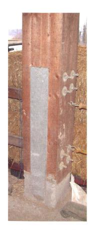
Holzstützen sind mittels Stahlprofile im Fundament eingespannt und erreichen damit eine sehr hohe Stabilität (Bild FAT).
