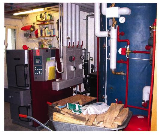
Für den optimalen Abbrand im Heizkessel der Stückholzfeuerung ist Wärmespeicherung für die dosierte Abgabe an die Radiatoren unumgänglich. Verbesserungen, neue messtechnische Verfahren und elektronische Regel-kreisläufe erlauben heute aber trotzdem den Teillastbetrieb zwischen 50 und 100% bei gutem Wirkungsgrad und möglichst vollständigem Sekundärabbrand der Schwelgase.
