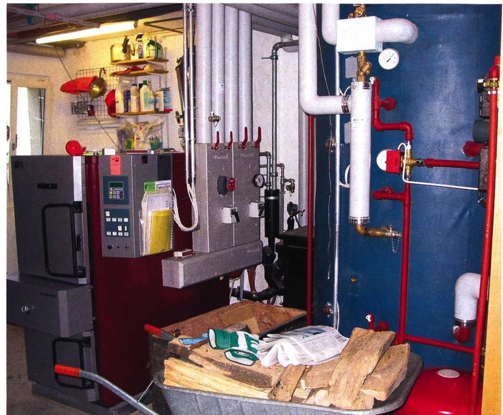
Für den optimalen Abbrand im Heizkessel der Stückholzfeuerung ist Wärmespeicherung für die dosierte Abgabe an die Radiatoren unumgänglich. Verbesserungen, neue messtechnische Verfahren und elektronische Regelkreisläufe erlauben heute aber trotzdem den Teillastbetrieb zwischen 50 und 100% bei gutem Wirkungsgrad und möglichst vollständigem Sekundärabbrand der Schwelgase.
