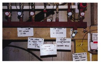
Kreisläufe für die Prozesswärme, die Warmwasseraufbereitung und im Sommer die Erwärmung der Lufstroms für die Heubelüftung sind übersichtlich angeordnet und gekennzeichnet. Die erbrachte Eigenleistung trägt insbesondere zum profunden Verständnis von physikalischen und biochemischen Zusammenhängen bei.
