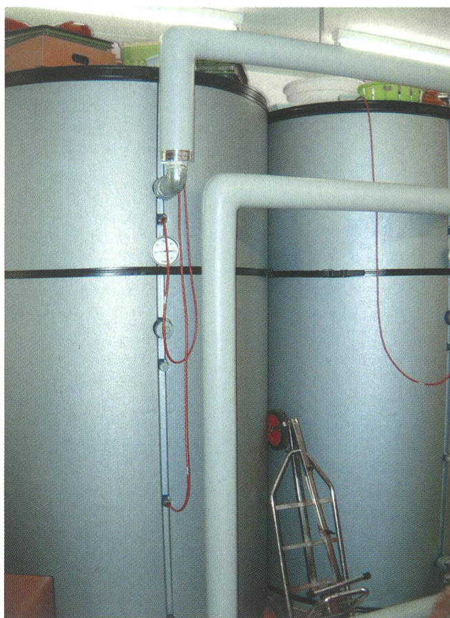
Zur modernen Stückholzfeuerung gehört aus Gründen der Luftreinhalteverordnung zwingend ein Warmwasserspeicher, in der Regel 12- bis 15mal so gross wie der Feuerungskessel.
