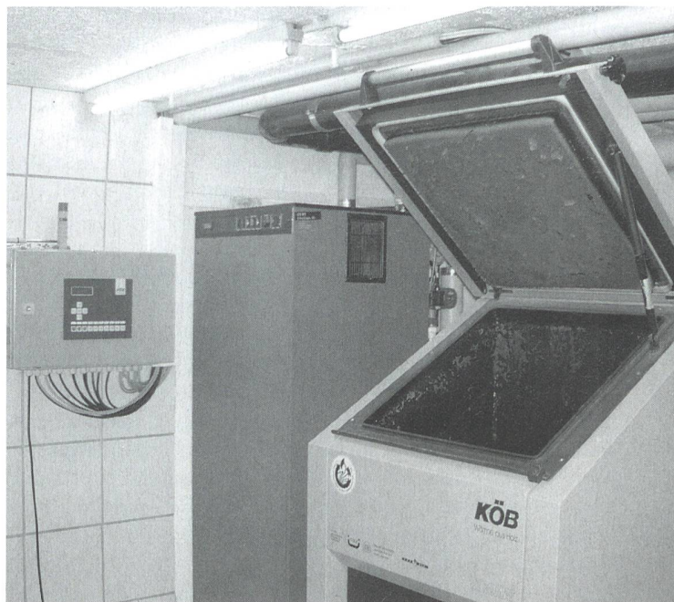
Köb-Heizkessel Pyromat, 35 kW. Die konische Form des Füllraums erleichtert das Nachrutschen des Holzes in den Bereich des Primär- abbrandes.
