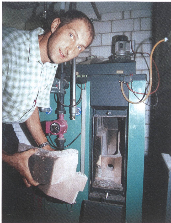
Blick in den schamottierten Sekundärabbrandraum des Heizmann-Holzvergaser-Kessels Modell HS 25PLC (35 kW). Die Holzgase werden unter Injektorwirkung im unteren Bereich mit der Sekundärluft verwirbelt und im Abbrandraum oxidiert und in die Wärmetauscher (Öffnungen links erkennbar) geleitet.
