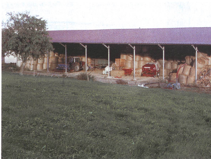
Halle in Fertigbauweise (45×16 m).
