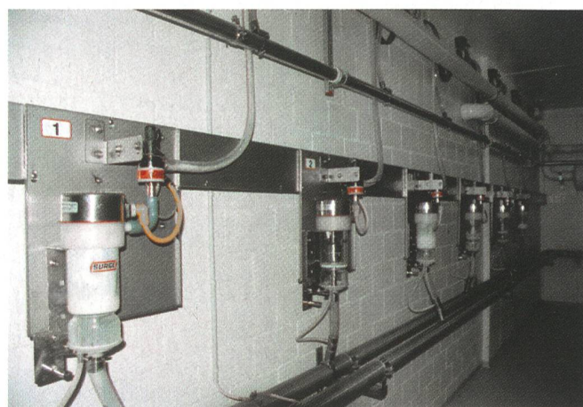
Blick in den «Subway» mit Milchmengenmessung, Elektronik und Rohrleitungen.
