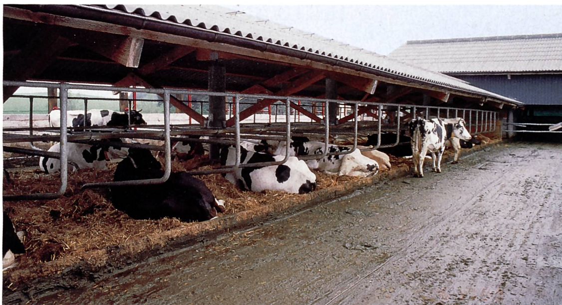
Umbaulösung Hallenstall nach Variante 3: Überdachter Liegebereich nach dem Muster des «Veloständers».
