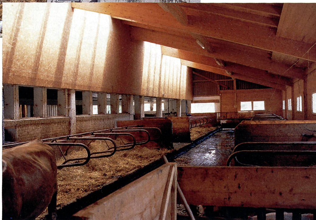
Umwandlung eines Anbindestalles in einen Laufstall durch seitlichen Anbau einer Liegeballe.
