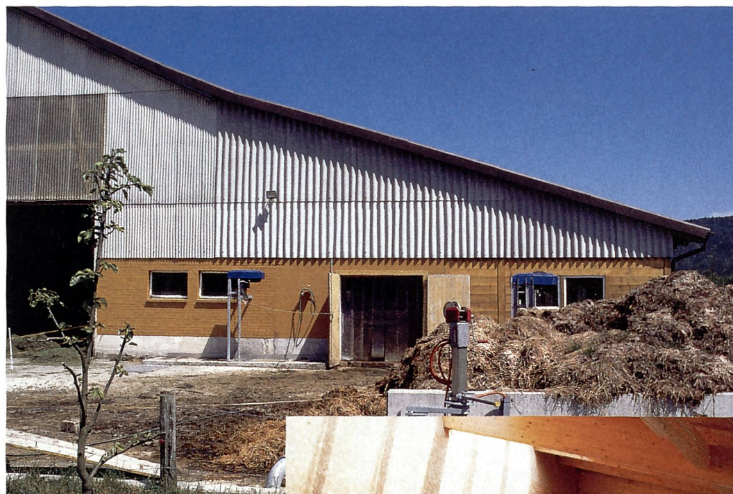
Umwandlung eines Anbindestalles in einen Laufstall durch seitlichen Anbau einer Liegeballe.
