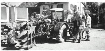
Ein rares Stück: Ein Hürlimann Typ 4 DT 47 von 1944 mit Hürlimann-Dieselmotor, Lizenz Saurer, und Elektro-Pflug Schmid. Das Fahrzeug wurde aus Luxemburg in die Schweiz zurückgebracht. Nach dem Krieg kam die Maschine in einer sog. Ackerbaukolonne in den Einsatz. Damit half die Schweiz 1945/46 beim Wiederaufbau der zerstörten Ländereien in Frankreich, Luxemburg und Italien.
