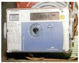
Mit dem Wärmezähler kann die produzierte Wärmeenergie gemessen werden. Es ist vorgesehen, dass nach Abschluss unserer Erhebung der Schnitzellieferant nach der produzierten Wärme bezahlt wird.
