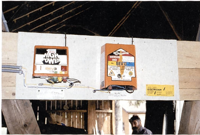
Vorbildlich installierte Elektrozaungeräte: Zaunzuleitung und Erdung sind entlang von Gebäuden mit Hochspannungskabeln in schwer entflammaren Rohren verlegt.
