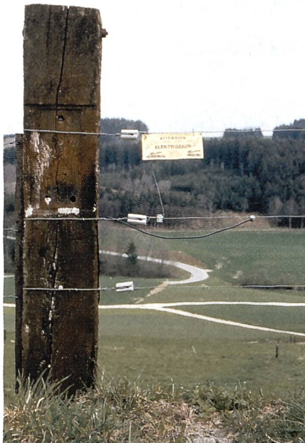
Feste elektrische Zäune bewähren sich auch in der Schaf- und Ziegenhaltung. Robuste Installationen gewähren eine hohe Hüttesicherheit und lange Lebensdauer.
