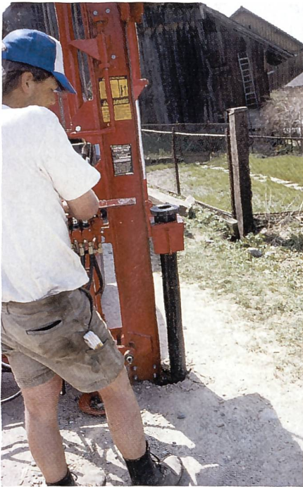
Rationelle Zaunerstellung mit der Pfabramme, die von einer erfahrenen Person bedient werden soll.
