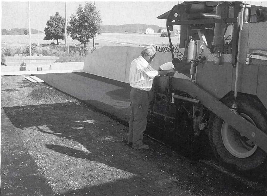
Abb. 1: Einbau des Walzasphaltbelags im Flachsilo an der FAT.
