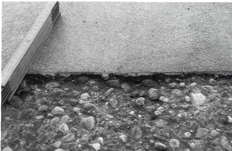
Abb. 10: Die Epoxiharz-Beschichtung (Streifen) im Flachsilo an der FAT ist nach sieben Jahren noch intakt.
