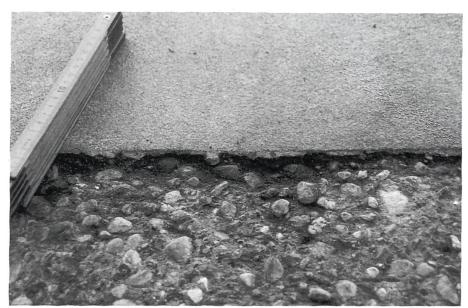
Abb. 10: Die Epoxiharz-Beschichtung (Streifen) im Flachsilo an der FAT ist nach sieben Jahren noch intakt.
