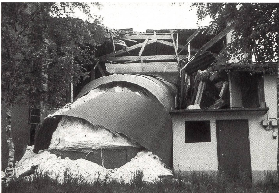
Abb. 2: Besonders wenn Silos auf Gebäude umstürzen, können hohe Sachschäden entstehen. In diesem Fall 150 000 Franken.
