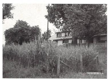
Schilfbestandener Bodenfilter mit Kontrollschacht der Kläranlage Oberebnet.
