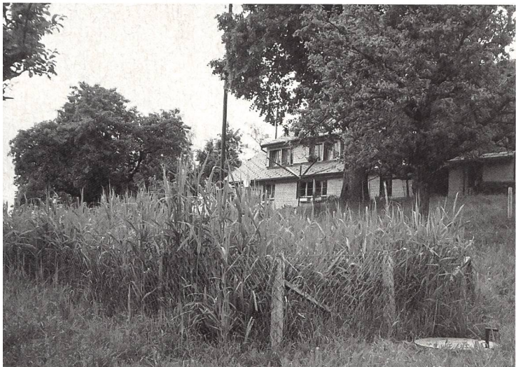
Schilfbestandener Bodenfilter mit Kontrollschacht der Kläranlage Oberebnet.
