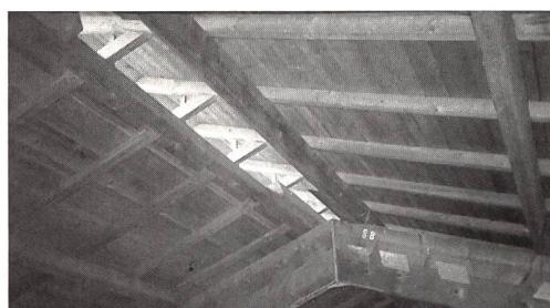
Eine Firstentlüftung in ungewöhnlicher Ausführung in einem Boxenlaufstall.
