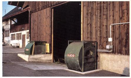
Diese mit Radiallüftern ausgerüstete Kaltbelüftung weist mit einem geteerten Vorplatz gute Ansaugbedingungen auf.
