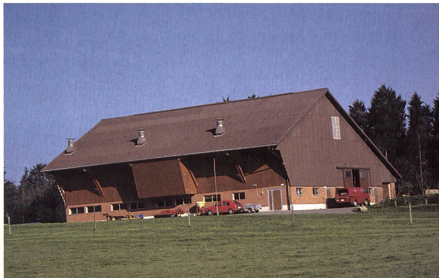
Sonnenkollektoren mit Eternitabdeckung sind von aussen nicht erkennbar. Sie können die Leistung der Belüftung ohne zusätzliche Fremdenergie verdoppeln und vermindern gleichzeitig die Lärmemissionen.
