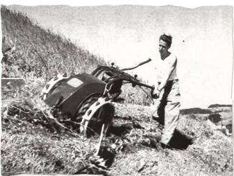
Der AEBI Motormäher AM 52 mit tiefer Schwerpunktlage, breiter Spur und erschütterungsarmen Führungssterzen eignete er sich hervorragend für den Hangeinsatz.
