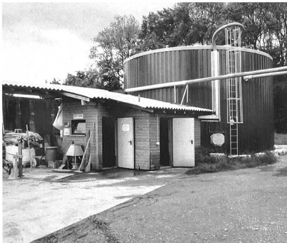
Abb. 1: Ansicht einer Biogasanlage
